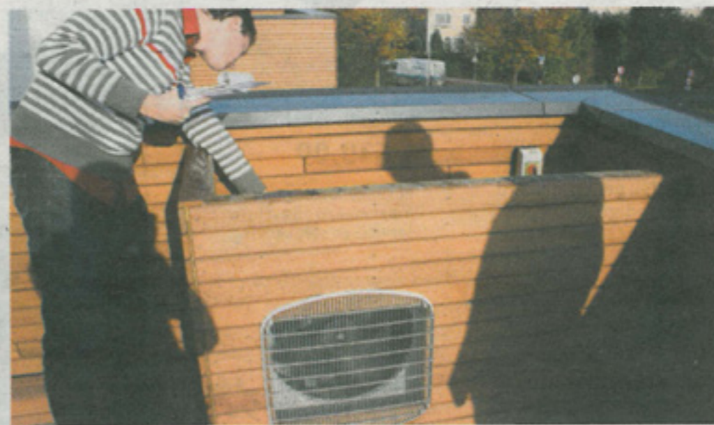
Een compleet ingepakt huis is geschikt om te verwarmen met een warmtepomp. FOTO PR
